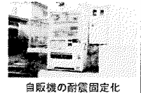
自販機の耐震固定化
