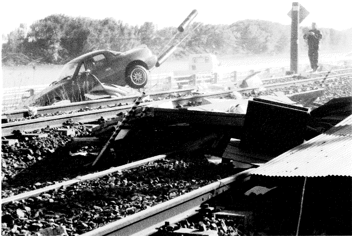
常磐線を超えて津波が襲った。北茨城市では津波により5名の方が亡くなった。 また、港湾・道路・市立病院など、産業基盤が大きな被害を受けた。
