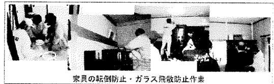
家具の転倒防止・ガラス飛散防止作業
