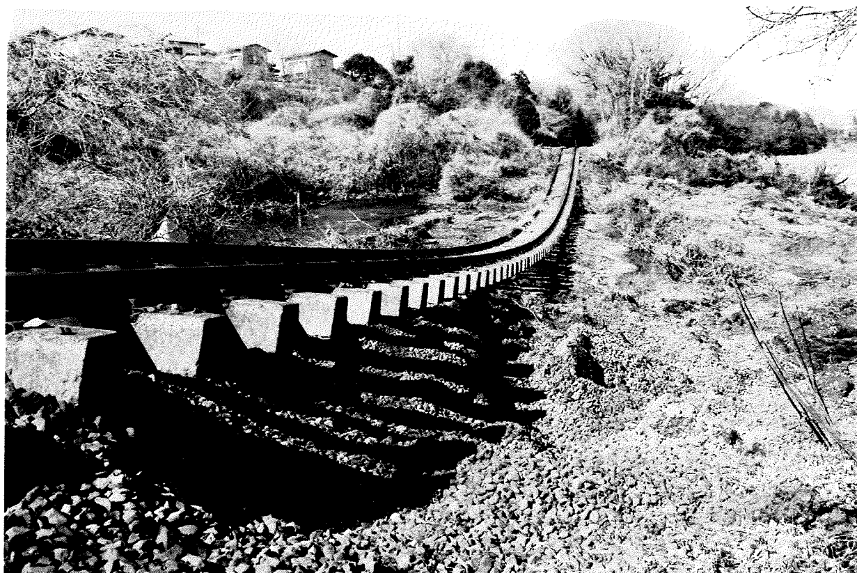
大きく湾曲したひたちなか海浜鉄道の線路。JR、高速道路などをはじめとする交通網の被害は県民生活に極めて大きな影響を及ぼした。
