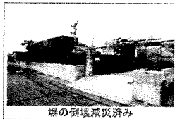
塀の倒壊減災済み
