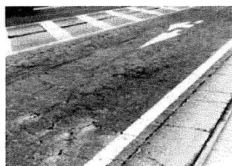
舗装修繕 茨城鹿島線(鉾田市)
