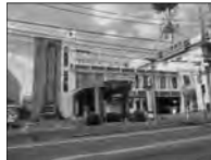
古河警察署現況 (S41年3月築)
