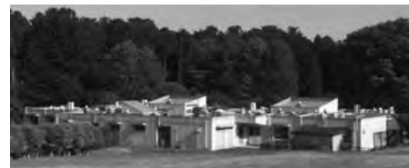
老朽化が進む入所施設（旧棟）
