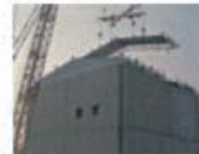
1号機原子炉建屋カバー屋根パネルの設置作業(2011年10月14日東京電力撮影)
