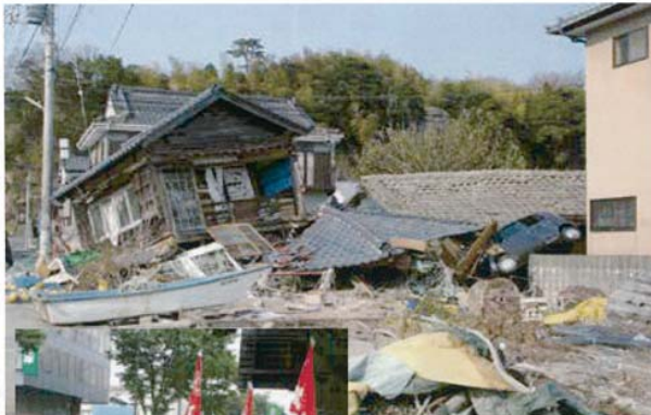
3.11 東日本大震災の津波で被害を受けた北茨城の大津港付近
