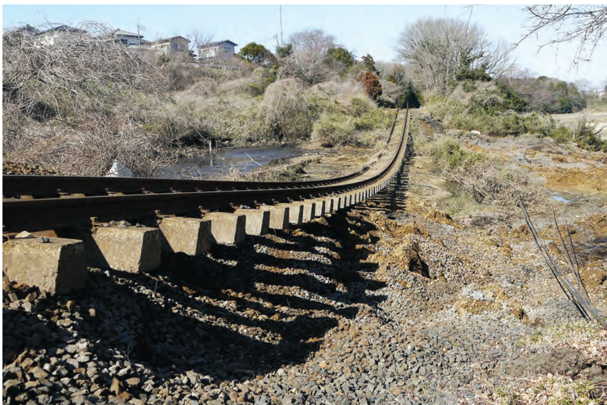
大きく湾曲したひたちなか海浜鉄道の線路。ＪＲ、高速道路などをはじめとする交通網の被害は県民生活に極めて大きな影響を及ぼした。
